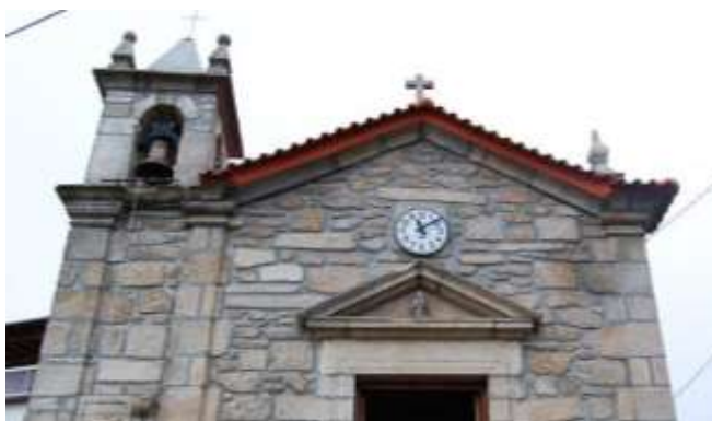
Figura 6: Igreja de Nossa Senhora das Neves
